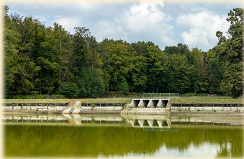
Kúvölgyi-tó völgyzáró gát
